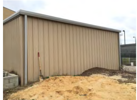
3). West Elevation - Dec 08, 2016
