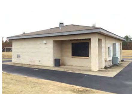
2). West Elevation - Dec 08, 2016
