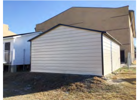
3). West Elevation - Dec 08, 2016
